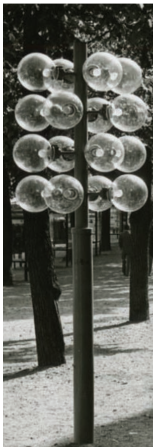
1960-talet. »Hyacinter« med glödlampor, i västra allén från 1968, i östra allén från tidigt 1960-tal. Ljuskällans höjd 3,6–3,7 meter till översta ljuspunkten.
